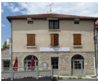
Fenêtres à l'encadrement en pierre obéissant aux dimensions, formes et couleurs de l'architecture traditionnelle
