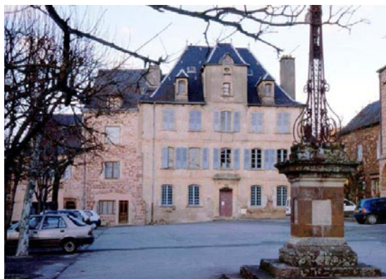
Dans l'architecture traditionnelle, les ouvertures sont généralement de forme verticale. Les dimensions et les formes sont souvent liées à la fonction de chaque pièce.
